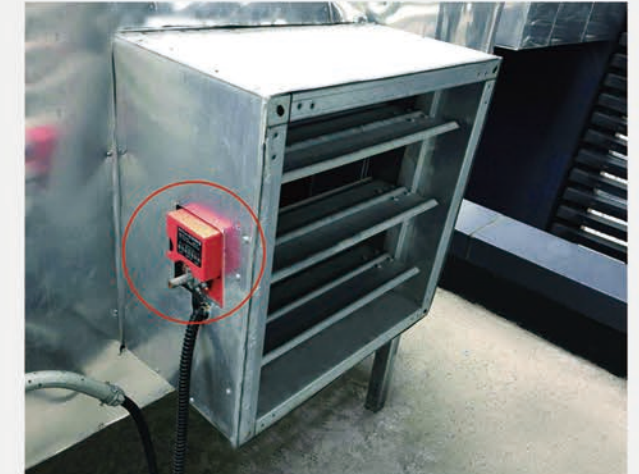
泄压阀执行器室外安装方式
